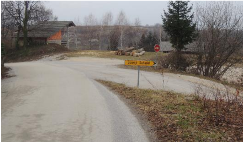
Slika 33: Nevarno križišče na Jugorju.
