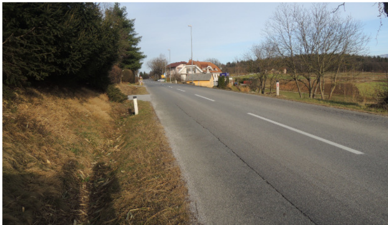
Slika 26: Nevaren cestni odsek brez pločnika na Ratežu.
