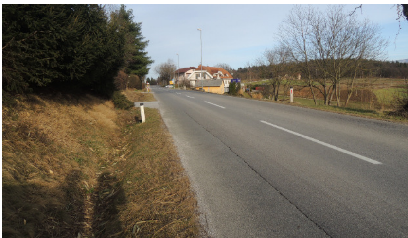
Slika 28: Nevaren cestni odsek brez pločnika na Ratežu.
